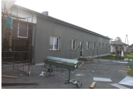
Prace remontowe przy OSP Wypychów
