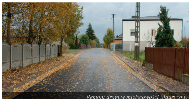
Remont drogi w miejscowości Mauryców.
