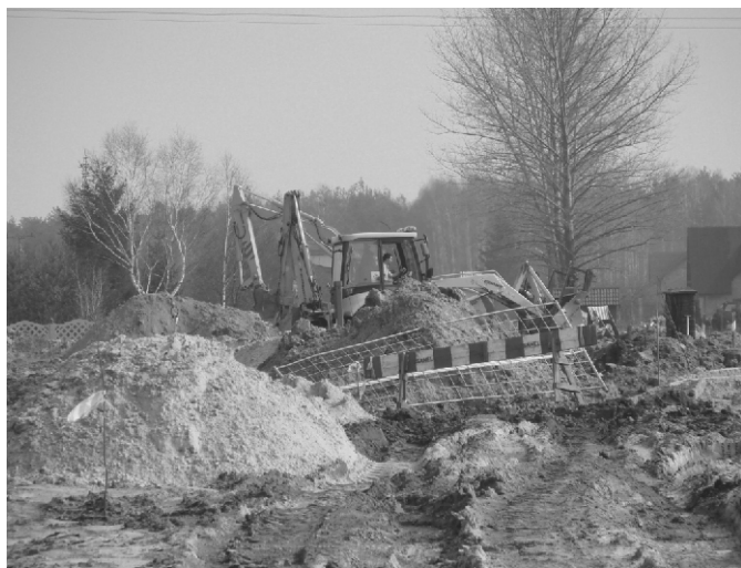
Prace na nieutwardzonym odcinku ulicy Wolności
