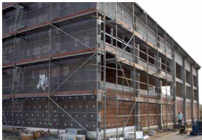
Budowa sali gimnastycznej przy Szkole Podstawowej Nr 2
